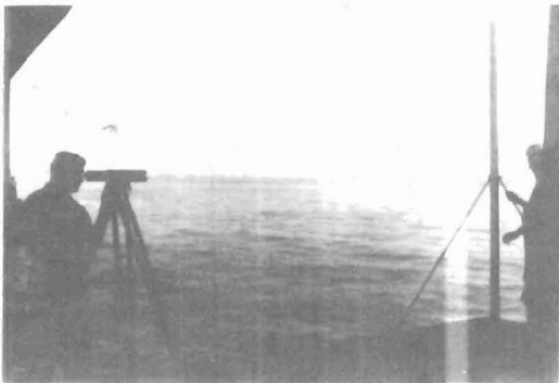
Foto 42.- Nivelación de alta precisión con nivel al y mira invar en las pilas del Puente sobre el lago.
