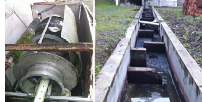
FIGURA 2. Tamiz de tambor rotario (izquierda) y trampa de grasa (derecha).
