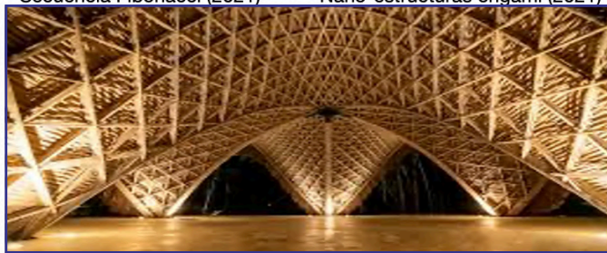
2 Arquitectura de Guadua-Bambú. Pabellón de Bambú (2019)
