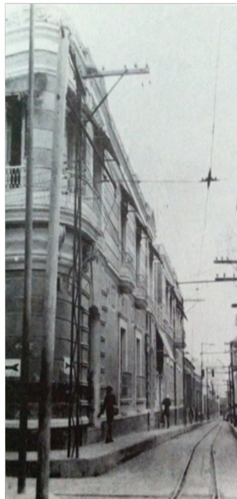
Figura 8. Vista parcial del Hotel Zulia. Fuente: Portillo(1998).
